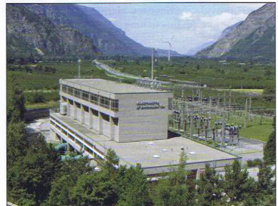
The powerhouse of 170 the MW La Bâtiaz hydro plant.
